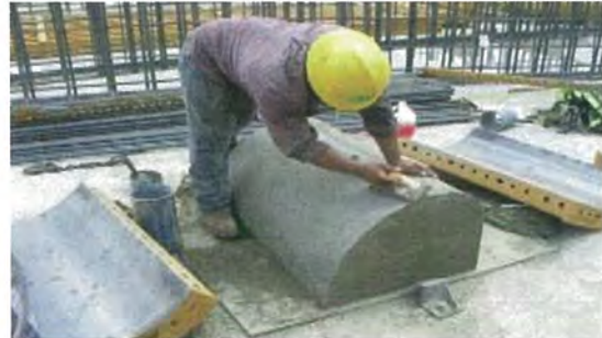
Labyrinth Wall Crest (test pour & finishing)
